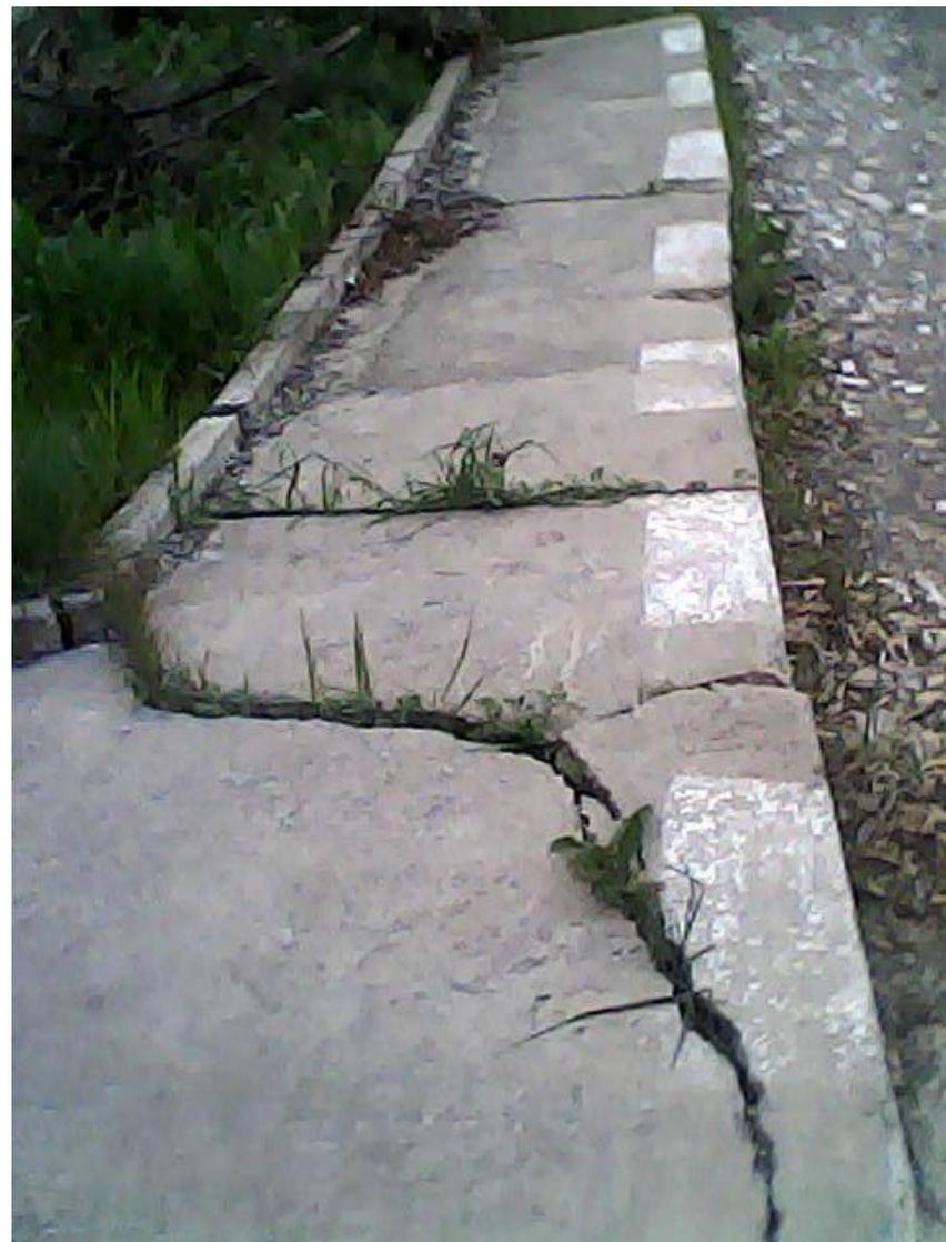
**Mur de clôture trop fissuré avec un déplacement important**
