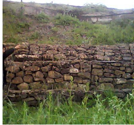
**Des murs de soutènements (gabionnage) ont subi des renversements et des contre-renversements**
